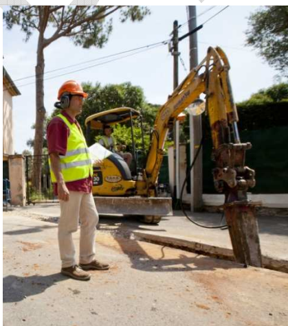
BRH monté sur mini-pelle
