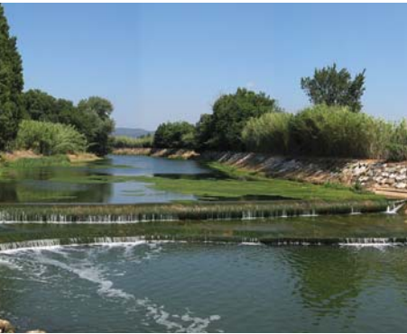
Digue gonflable amovible en période de crues sur le Gapeau. Elle maintient la nappe en charge et empêche la remontée du biseau salé. © BRGM - J. CASANOVA
