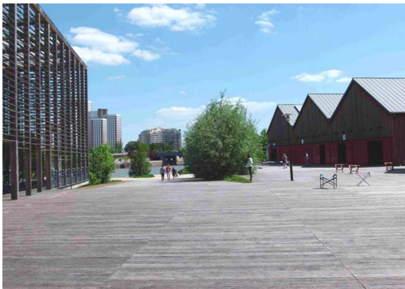
Cette esplanade de 16 000 m 2 a été réalisée avec du chêne français (résistance classe 4 sans traitement, certifié PEFC ) en platelage épais (45 mm), fabriqué en France (SAS Eurochêne – Jura). Les hangars à bateaux (à droite) sont également en bois tout comme le pare soleil du bâtiment de gauche.
