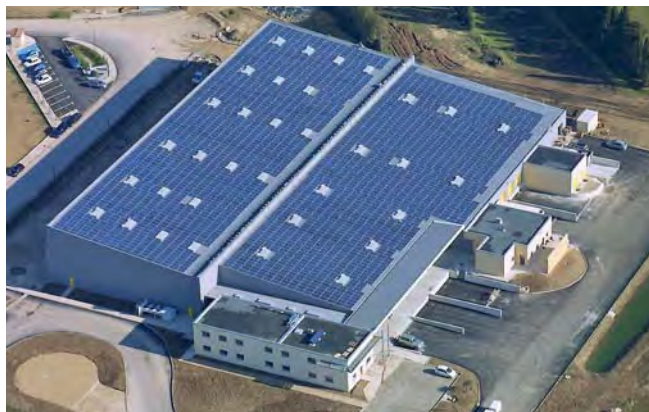
© Ciel et Terre - Europe Vue du Ciel - Centrale photovoltaïque du Relais Vert Coopérative de produits biologiques (84)
