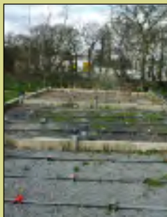
● TROIS FILTRES ETANCHES L'étanchéité du filtre est assurée par des murs en parpaings banchés (20 cm). Des roseaux y ont été plantés à raison de 4 pieds/m 2 .
