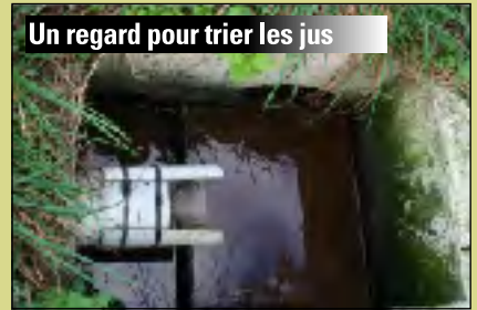
Un regard pour trier les jus ● Quand il pleut beaucoup, les jus rejoignent le BTS. Sinon, en tournant le tuyau, ils peuvent être dirigés vers la fosse où ils retrouvent les eaux blanches.
