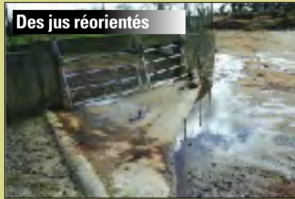
Des jus réorientés ● Les jus ne s'écoulent plus dans la fosse. Un "dôme" en ciment les dirige vers un regard situé derrière la fosse.
