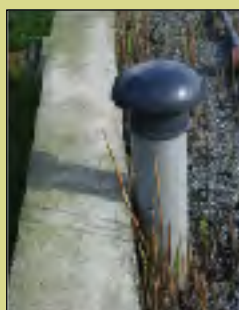
● CHEMINÉES ET DRAINS D'AÉRATION Elles sont disposées dans les angles de chaque bassin et reliées à des tuyaux horizontaux installés à mi-profondeur (environ 60 cm). Ils favorisent l'apport d'oxygène.
