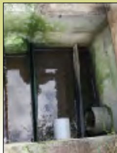
● TROIS FILTRES ETANCHES L'étanchéité du filtre est assurée par des murs en parpaings banchés (20 cm). Des roseaux y ont été plantés à raison de 4 pieds/m 2 .
