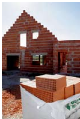
Exemple d'utilisation de la brique alvéolée
